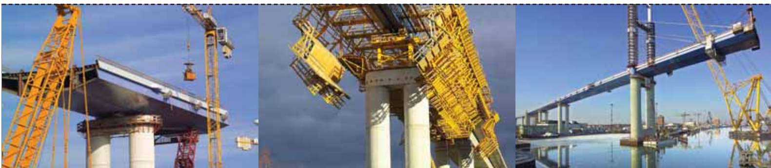
Bildnachweis/Quelle: R. Legrand, im Auftrag der DEGES und Firmengruppe Max Bögl.
